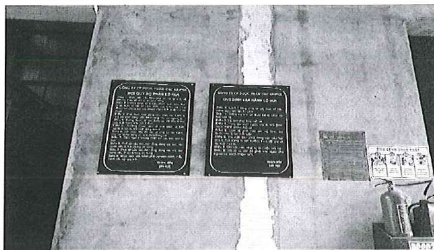
Hình 3-7: Khu vực lò hơi tại nhà máy
