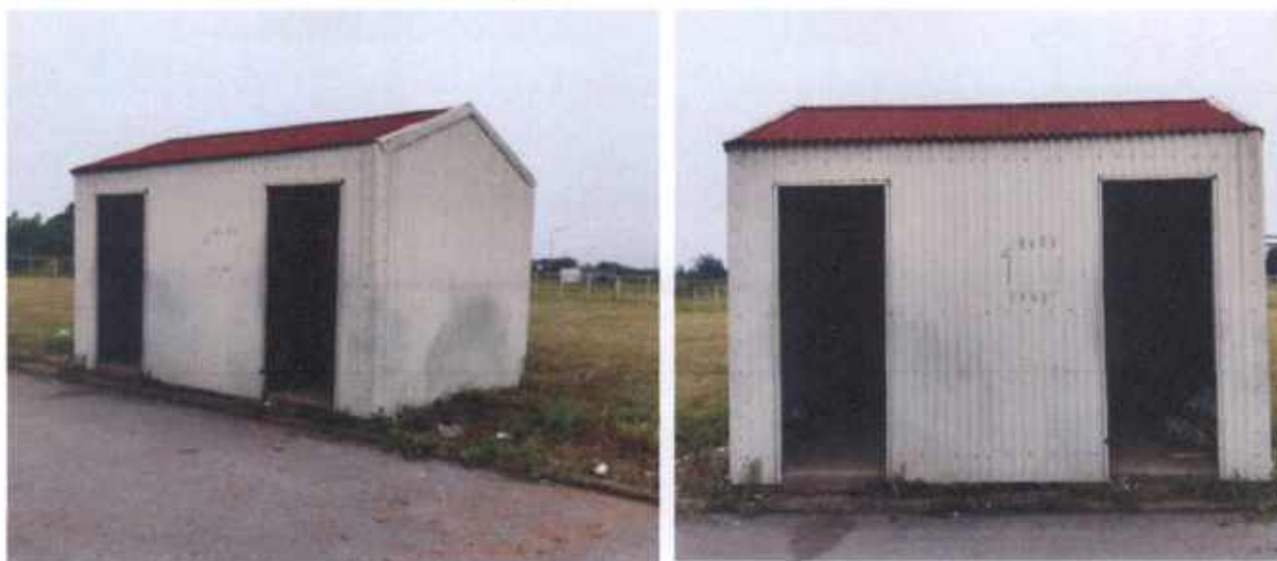
Hình 3-15: Hình ảnh kho chứa chất thải rắn công nghiệp thông thường
