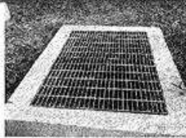
Hình 8 Hồ ga cuối thoát nước thải của dự án
