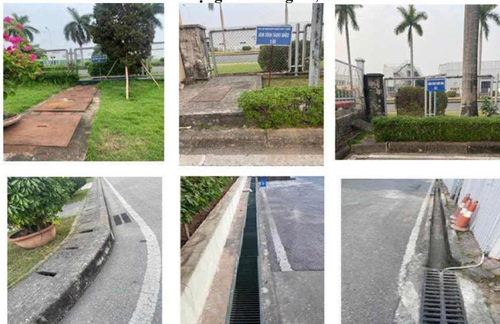
Hình 23. Hệ thống thu gom, thoát nước mưa
