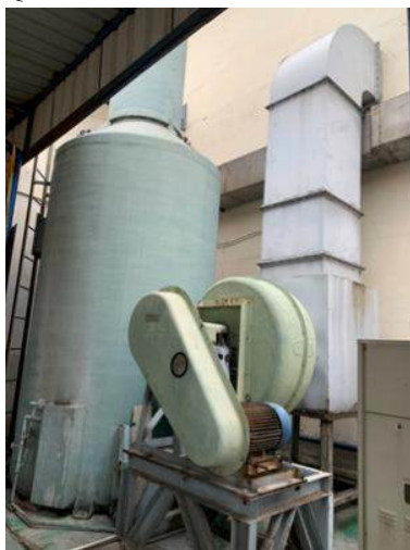
Hình 37. Tháp hấp thụ và ống khói của Hệ thống xử lý khí thải dây chuyền Phốt phát
