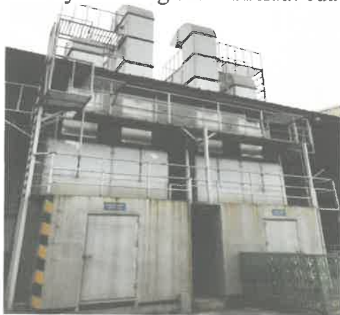
Hình 3.11. Hình ảnh hệ thống xử lý khí thải phòng sơn
