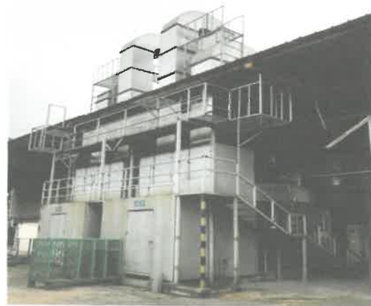
Hình 3.11. Hình ảnh hệ thống xử lý khí thải phòng sơn
